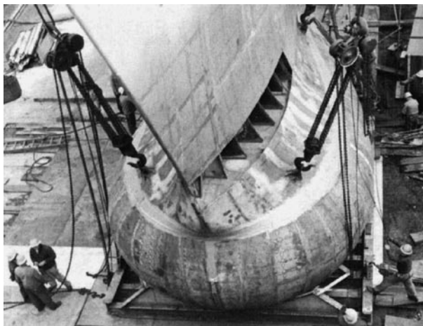
Монтаж ГАС AN/SQS-53 в носовом обтекателе
